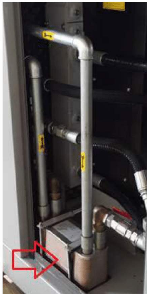
Рис. 1 Пример теплообменника, устанавливаемого на компрессоре
